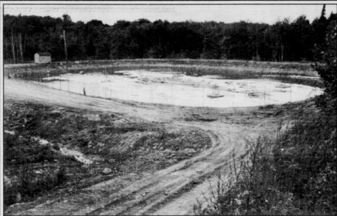
Des représentants du MEF se sont rendus sur place fin février et ont effectivement constaté que des aérateurs et des lampadaires avaient été enlevés. photo d'archives
