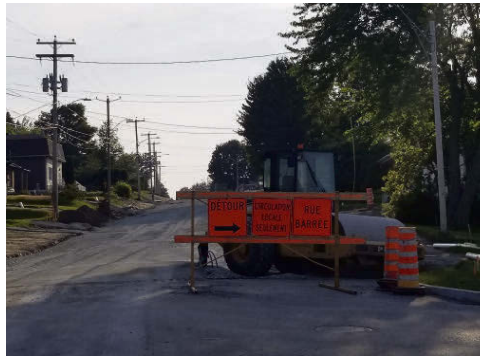
Les travaux vont bons trains dans les rues d'Asbestos
