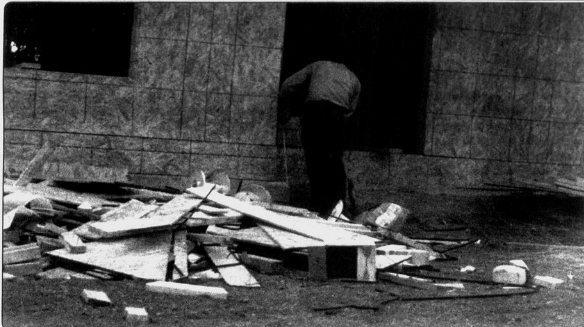
Si vous aimez la construction et si vous avez une grande dextérité, vous pouvez étudier en charpenterie-menuiserie.
