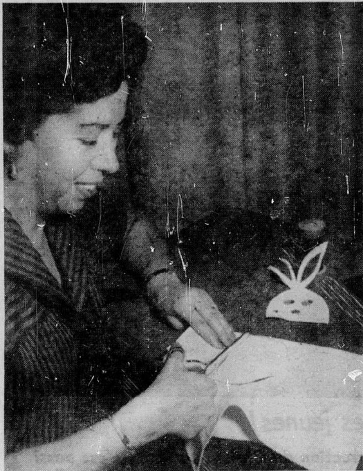
JEANNOT LAPIN apparaît sous les ciseaux habiles de maman qui a dessiné la forme au préalable, sur l'épais tissu. Quelques appliqués deviennent les oreilles, les yeux, le nez et la bouche. Le contour est répété pour confectionner l'arrière de la tête et le tout est cousu, laissant évidemment une ouverture dans le bas pour passer l'oeuf.
