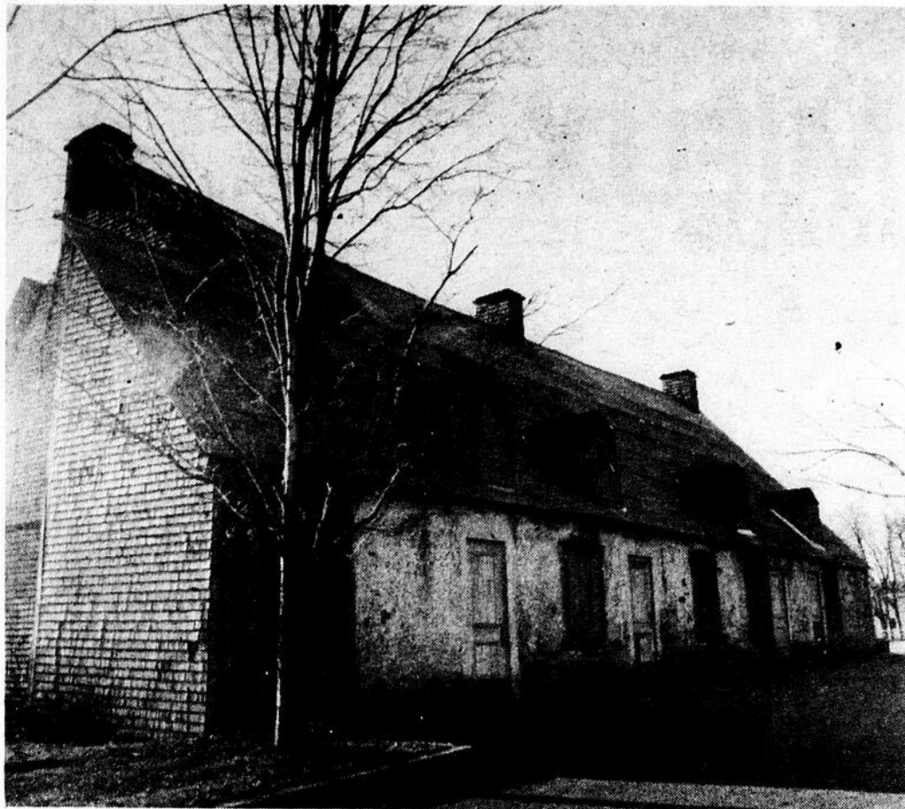
Le vieux presbytère de St-François est coiffé d'un toit neuf, réalisation insérée dans l'opération sauvetage du bâtiment rendue possible grâce à une subvention de 26 000$ du ministère des Affaires culturelles.
