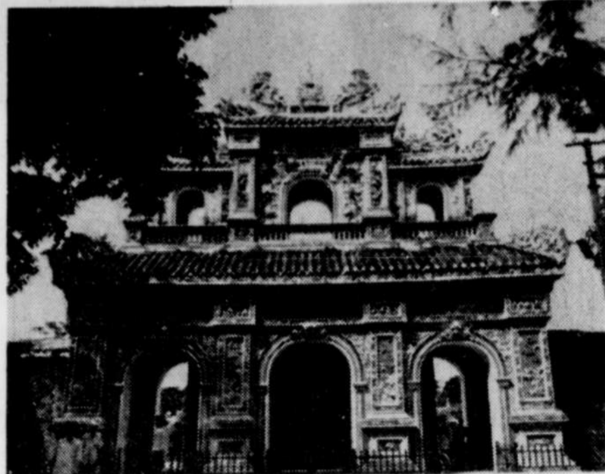
Façade est de Hien Nhon Mon, pavillon d'entrée de la Cité impériale restauré par les techniciens vietnamiens.
