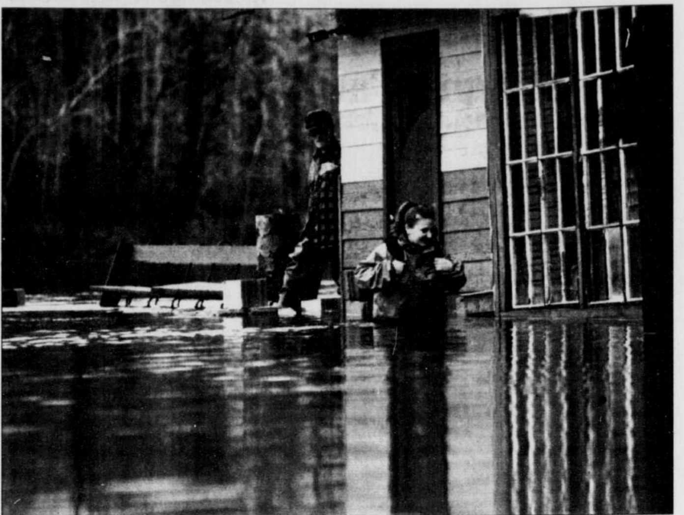
L'eau a fait des ravages dans cet édifice situé à proximité de la rivière Mattagami, à Timmins, dans le nord-est de l'Ontario.
