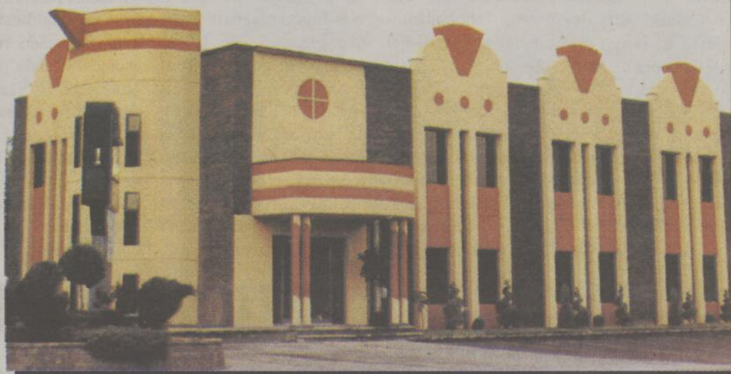
L'esterno del complesso "Le Marco" interamente rinnovato
