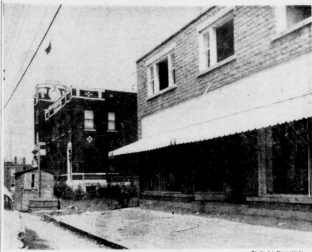
LES TRAVAUX DE CONSTRUCTION au bureau de poste du Cap-de-la-Madeleine semblent être sur le point de commencer. C'est du moins ce que l'on croit avoir vu le début de la démolition de la maison Garneau, à l'angle des rues Toupin et Brunelle. L'entrepreneur Rosaire Dufresne a transporté quelques pièces de machinerie sur les lieux. Il nous a été impossible d'obtenir de plus amples renseignements sur le projet en cours. On sait que la nouvelle avait d'abord été annoncée, il y a quelques mois, par le député Irène Rochefort.
