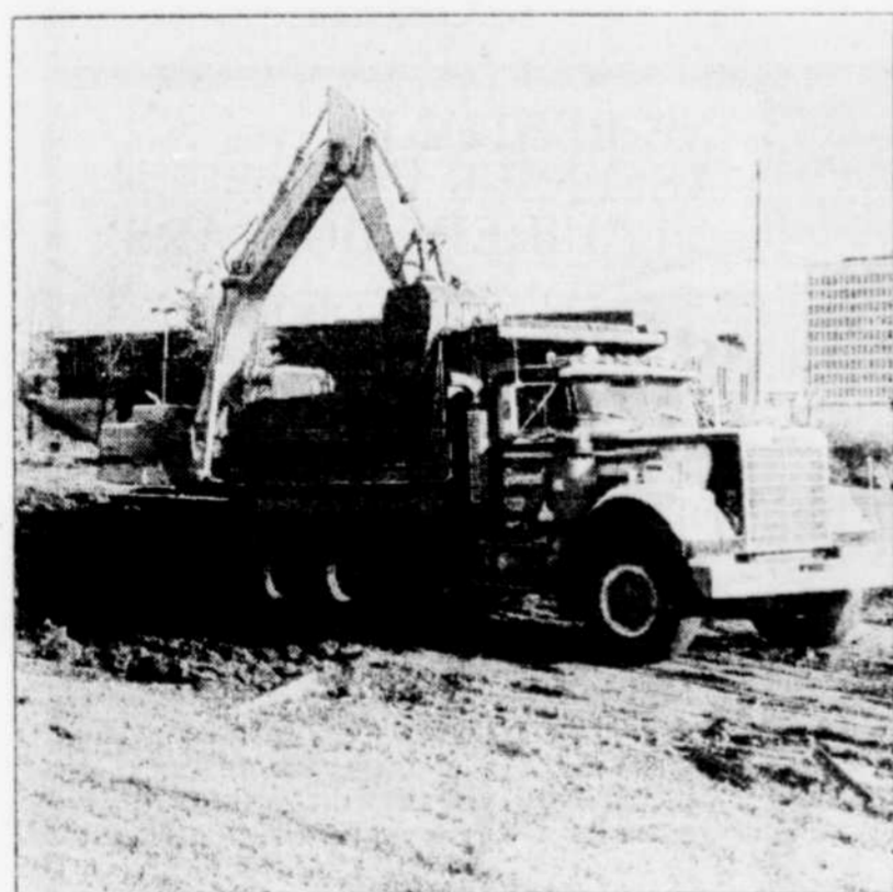
Les travaux d'excavation ont débuté, hier matin, sur le terrain où l'homme d'affaires Raymond Malenfant projette de construire un ensemble hôtelier de $14 millions sur le boulevard Laurier.
