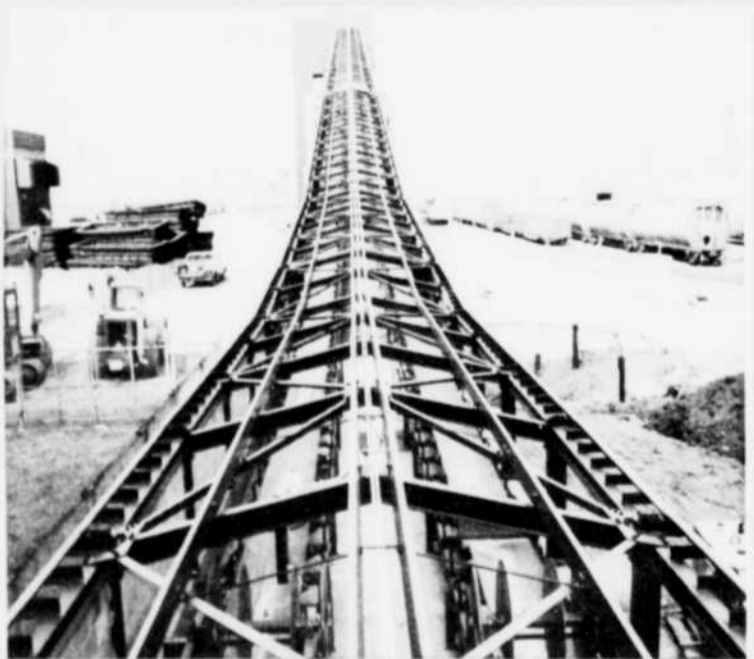
Des montagnes russes? Non, la nouvelle courroie de l'Usine Vaudreuil pour transporter l'alumine. C'est à s'y méprendre. (Photo Jean Matteau)
