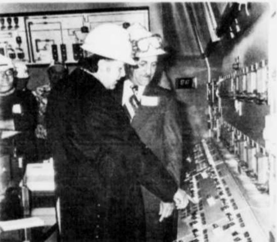
Lors de l'inauguration du Centre des produits cathodiques le 9 novembre 1978, Bernard Landry, ministre d'État au développement économique, a donné le coup d'envoi avec Maurice Danis, doyen de l'Usine Arvida.
