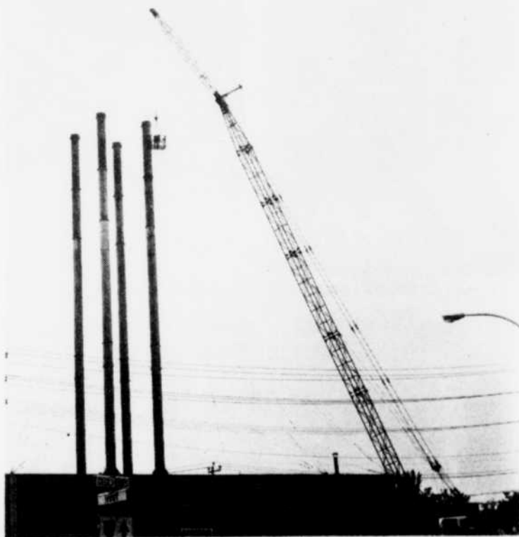
L'entretien d'une usine suppose une multitude de tâches, dont plusieurs sont fort impressionnantes. À preuve, cette scène qu'a croquée notre photographe Yves Henrichon, lors de récents travaux d'entretien annuel de l'Usine Lapointe.
