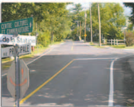
Rue de la Station/principale – pavage
