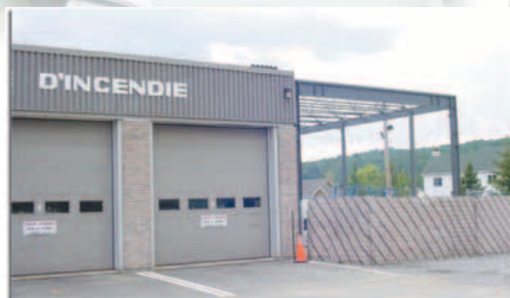
Agrandissement de la caserne incendie
