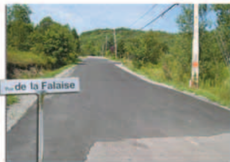
Rue de la Falaise – pavage
