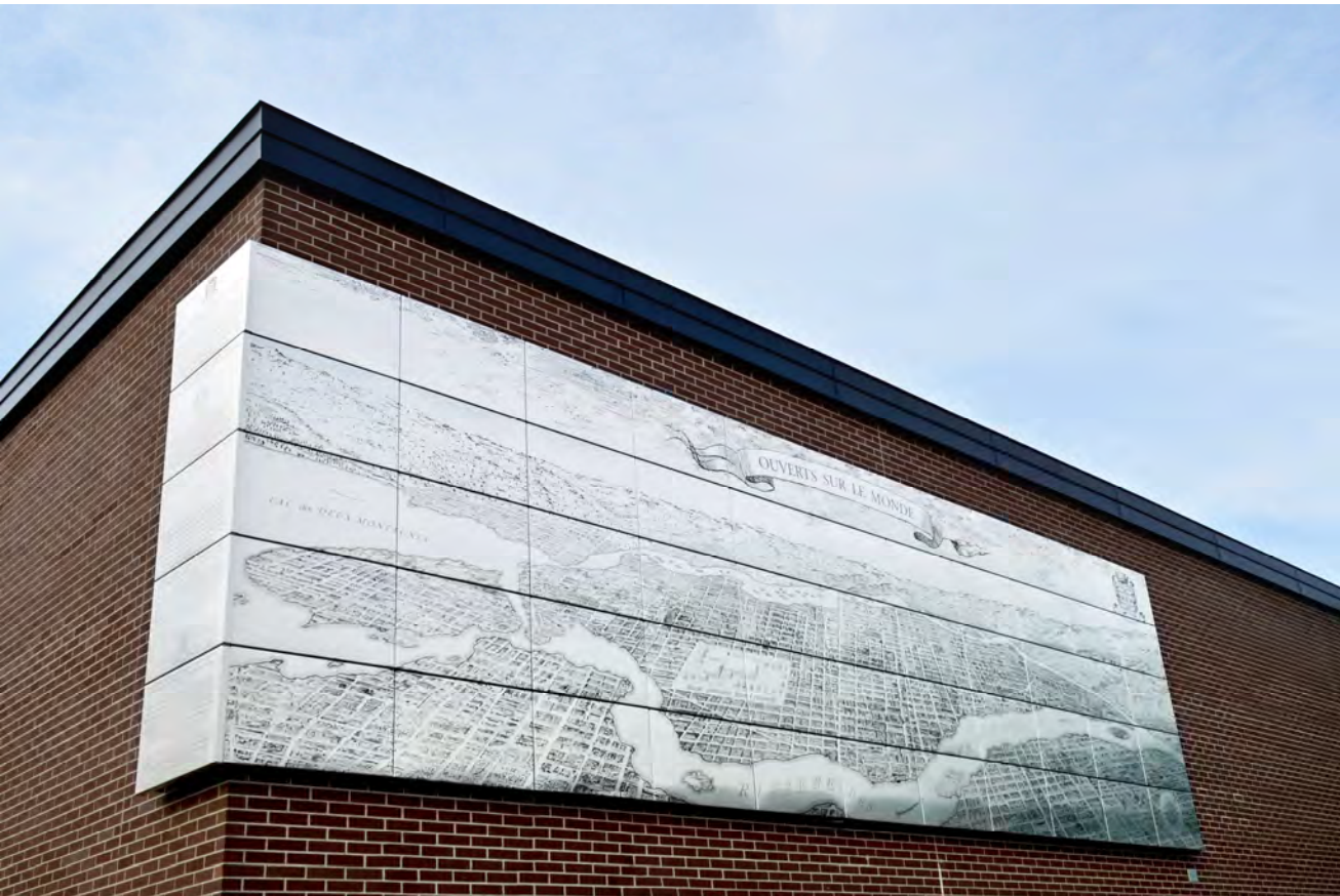
Ouverts sur le monde , 2014 Acier inoxydable gravé au laser École primaire Jean-Lemondé, Laval Architectes : Bergeron Bouthillier Architectes Photographies : Alyson Drouin / MCC
