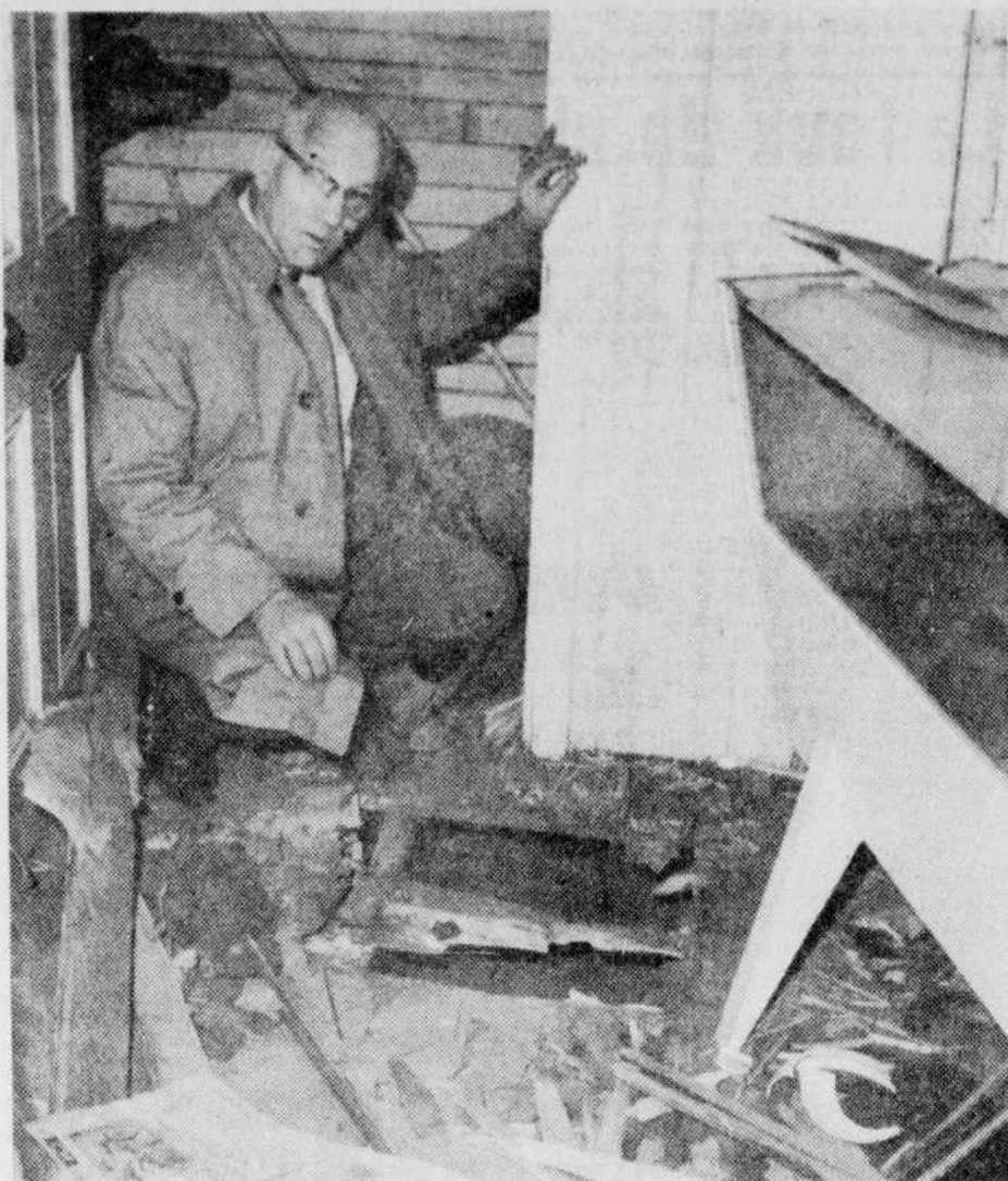
TROU DANS LE PLANCHER — Le propriétaire de la bijouterie Robert, M. Robert Karunum, montre où les voleurs ont percé un trou, dans le plancher du premier étage, pour s'infiltrer, à l'abri des regards, jusqu'au rez-de-chaussée.
