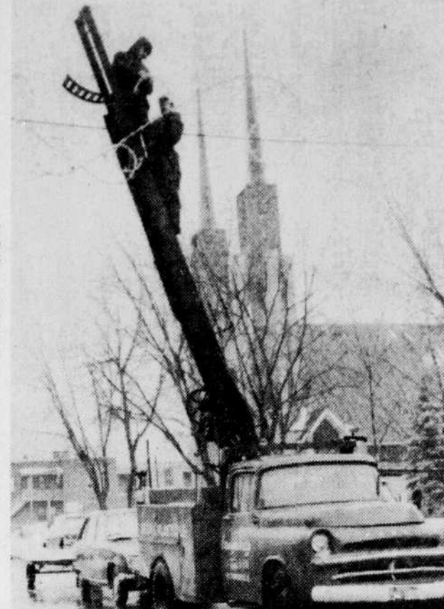
CA SENT LA PERIODE DES FETES — La ville-reine des Bois-Francs revêt actuellement ses plus beaux atours à l'occasion de la prochaine période des fêtes. Hier, on procédait à l'installation des lumières scintillantes qui illumineront de mille éclats le secteur commercial. Il s'agit là d'une initiative renouvelée de la Jeune chambre en collaboration avec les marchands locaux.
