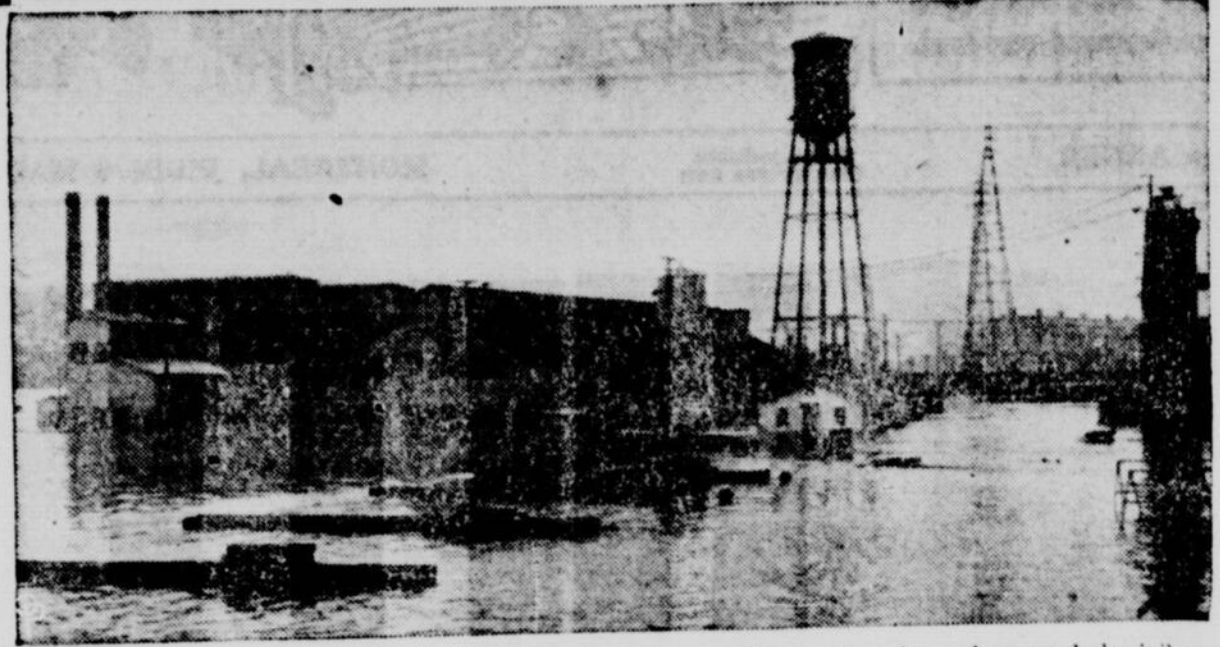
Le chantier maritime de l'American Bridge Company est complètement inondé par les eaux de la rivière Ohio, à Pittsburgh, avec le résultat qu'en a été obligé de fermer l'usine. L'eau qui couvre une partie des principaux édifices monte encore.
