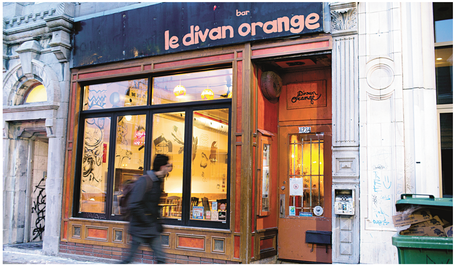
Le Divan orange est à quelques semaines de prendre possession du deuxième étage vide et d'y faire des travaux pour mettre sur pied le Centre de diffusion des musiques émergentes. Mais l'accumulation des amendes met en péril ce projet.
