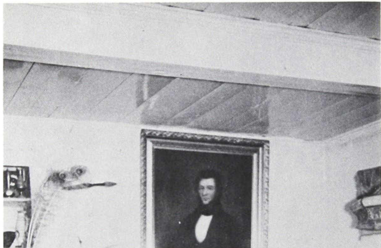
Le plus simple des assemblages: les poutres et les madriers du plancher de l'étage sont apparents.
