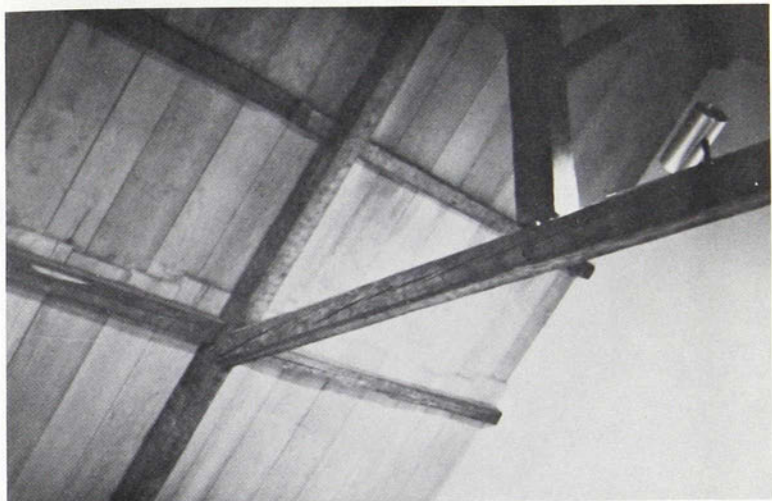
Charpente de 1781. On remarque la grande distance existant entre les fermes ainsi que l'absence de chevrons. Les planches du toit sont posées directement sur les pannes dans le sens vertical.
