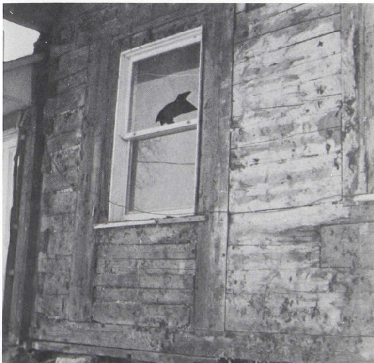
Sur cette maison de bois en cours de restauration, on voit que les jambages de l'ancienne fenêtre font partie intégrante du mur.
