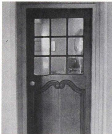
Porte de chambre vitrée, à panneau chantourné. On peut voir la finesse d'exécution et le souci du détail de cette réalisation.
