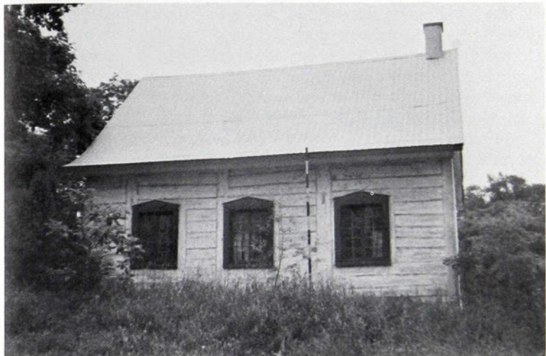
Maison aux murs pièce sur pièce chaulés...
