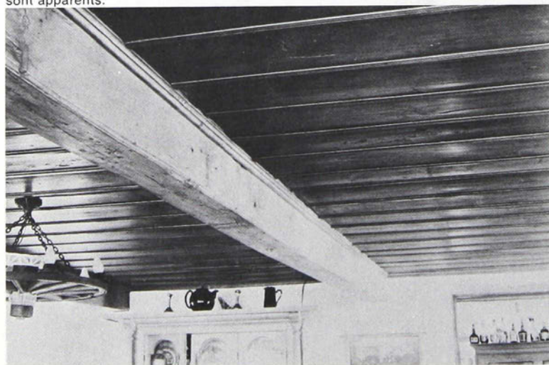
Ici, un plafond de planches a été cloué sous les madriers du plancher de l'étage. La poutre est encore apparente.
