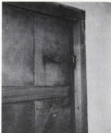
Détail d'une porte de chambre aménagée dans un grenier: il s'agit d'un simple assemblage de planches, ce qui donne à l'ensemble un cachet de «rusticité voulue».
