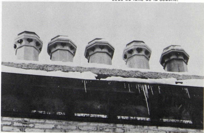
Ceux qui ont la chance de posséder de tels mitrons, comme on peut encore en trouver sur certaines maisons du siècle dernier, doivent absolument les conserver.
