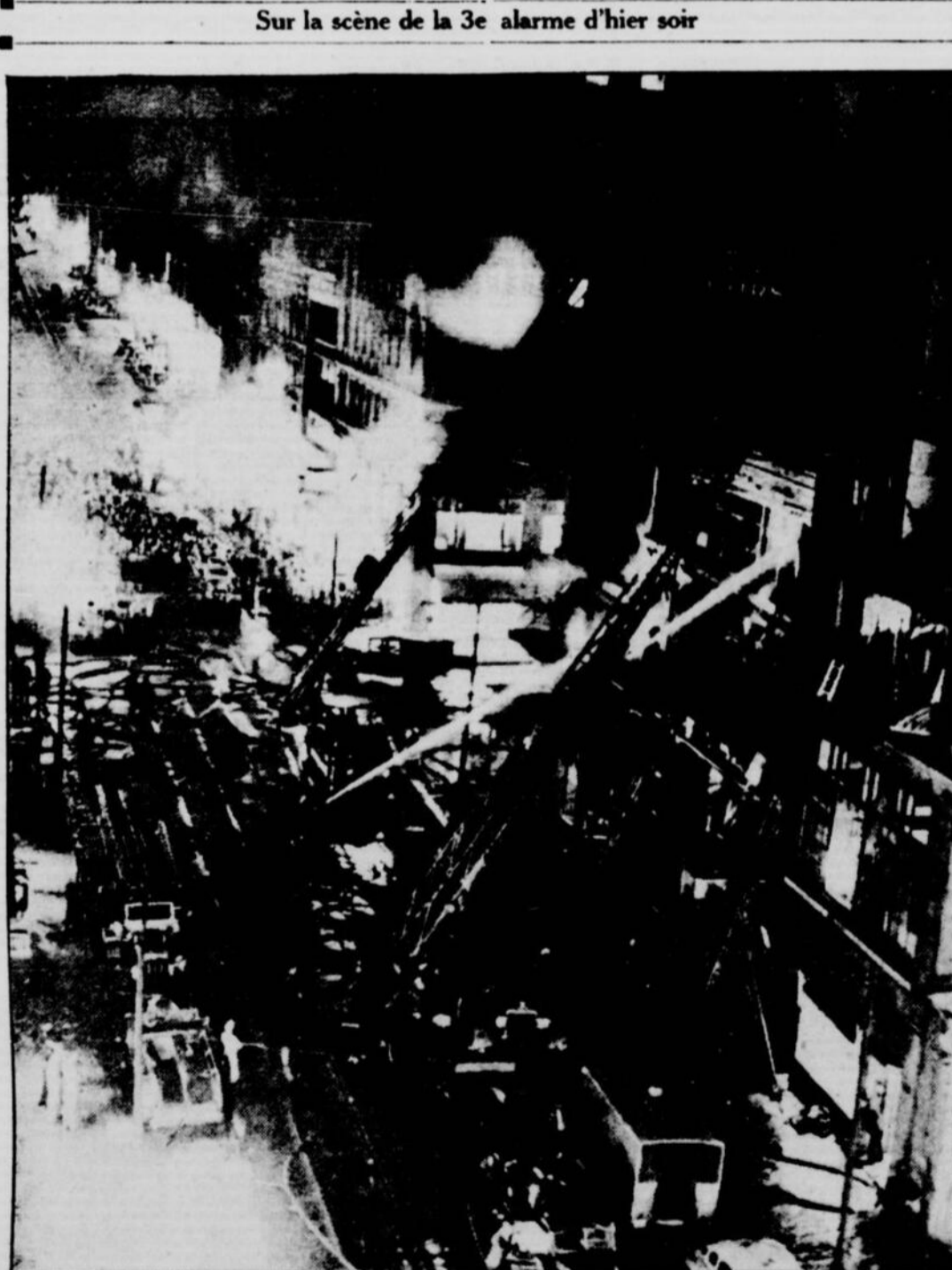
Saisissante photo prise vers 10 heures, hier soir, du toit d'un édifice voisin du théâtre du terrible incendie qui nécessita trois alarmes, à l'angle des rues Sainte-Catherine et Stanley. 15 pompiers furent blessés et 4 magasins furent ravagés. A noter l'amas confus de boyaux, en plein milieu de la rue Sainte-Catherine. (Photo la "Patrie")
