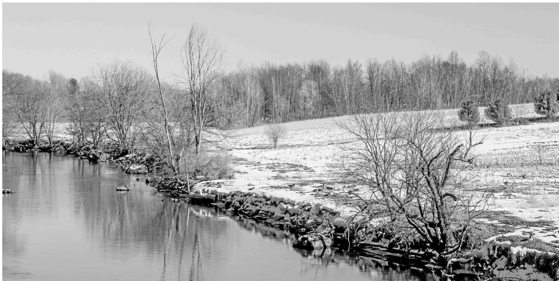
Sur certaines terres agricoles, la MRC procédera à l'implantation d'un chenal à deux niveaux, qui permettra à l'eau de déborder dans une plaine végétalisée plutôt que d'aller directement dans un cours d'eau. — PHOTO FOURNIE PAR LA MRC
