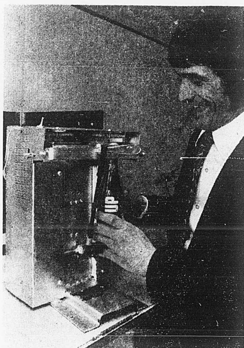
Jean Baulne, un ancien des "Baronets", présente une nouvelle invention de son cru: un décapsuleur électrique qui enlève le bouchon d'une bouteille d'eau gazeuse en un tour de main et sans effort. Le prototype a un aspect rudimentaire, pour le moment, mais il fonctionne!
