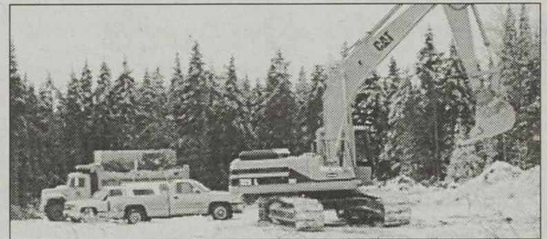
Les travaux de construction de l'usine sont déjà en marche.
