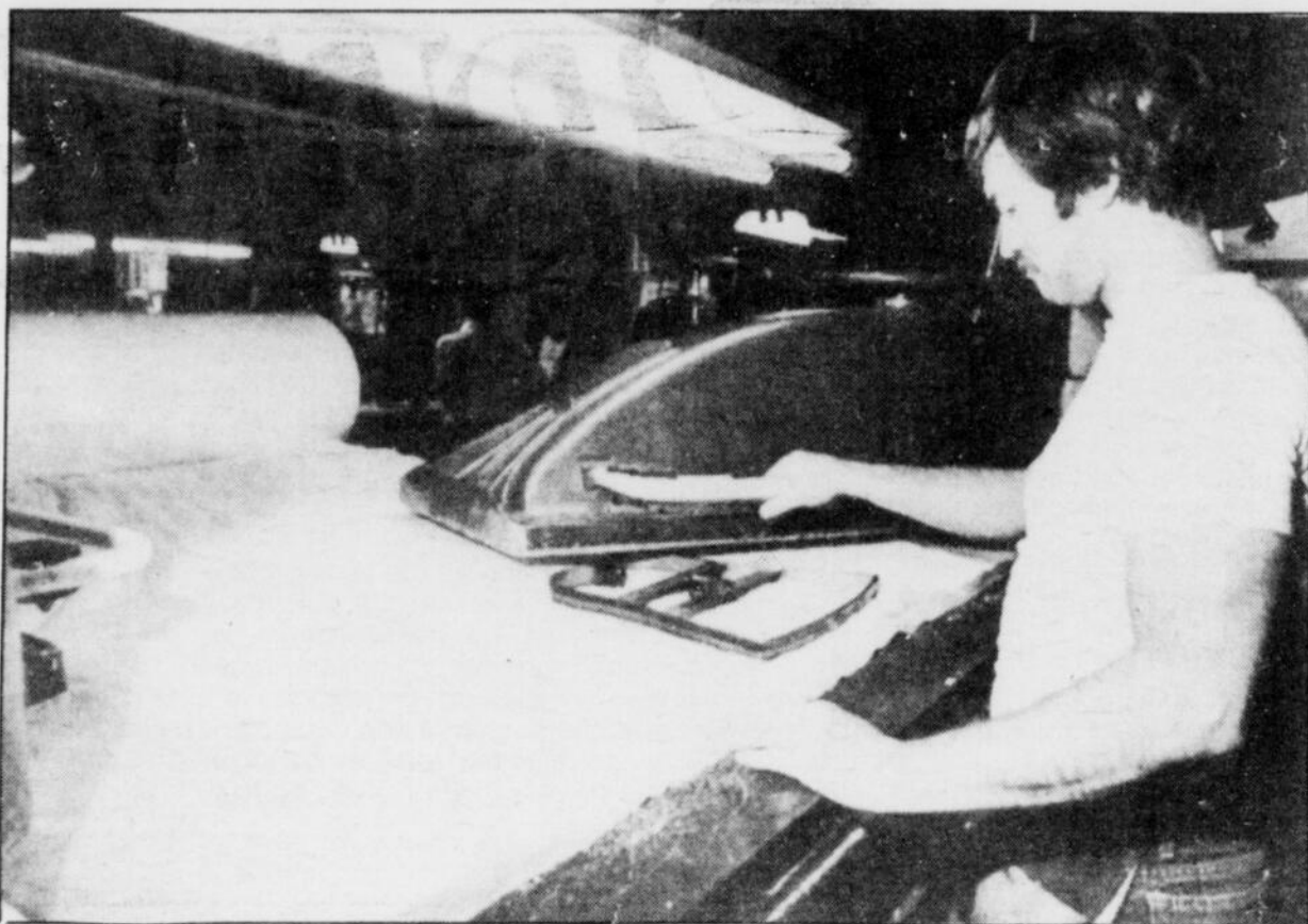
Un employé s'apprête à couper une partie d'un rouleau de dacron avec un moule. Le matériel s'ajustera parfaitement à l'intérieur d'une mitaine.
