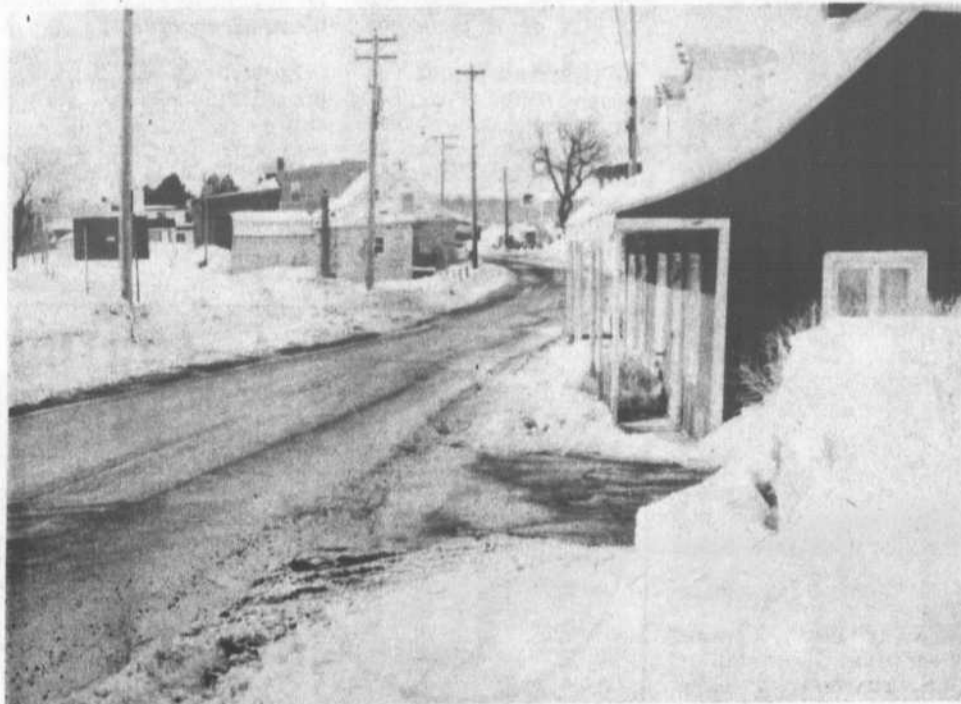
Les piétons qui circulent sur la rue Ste-Marie pour la première fois, sont toujours surpris lorsqu'ils arrivent en face de cette maison car le perron de celle-ci semble être la continuation du trottoir qui borde la rue. Pour apporter une solution aux risques engendrés par cette situation, le conseil étudie actuellement la possibilité d'exproprier cette maison.
