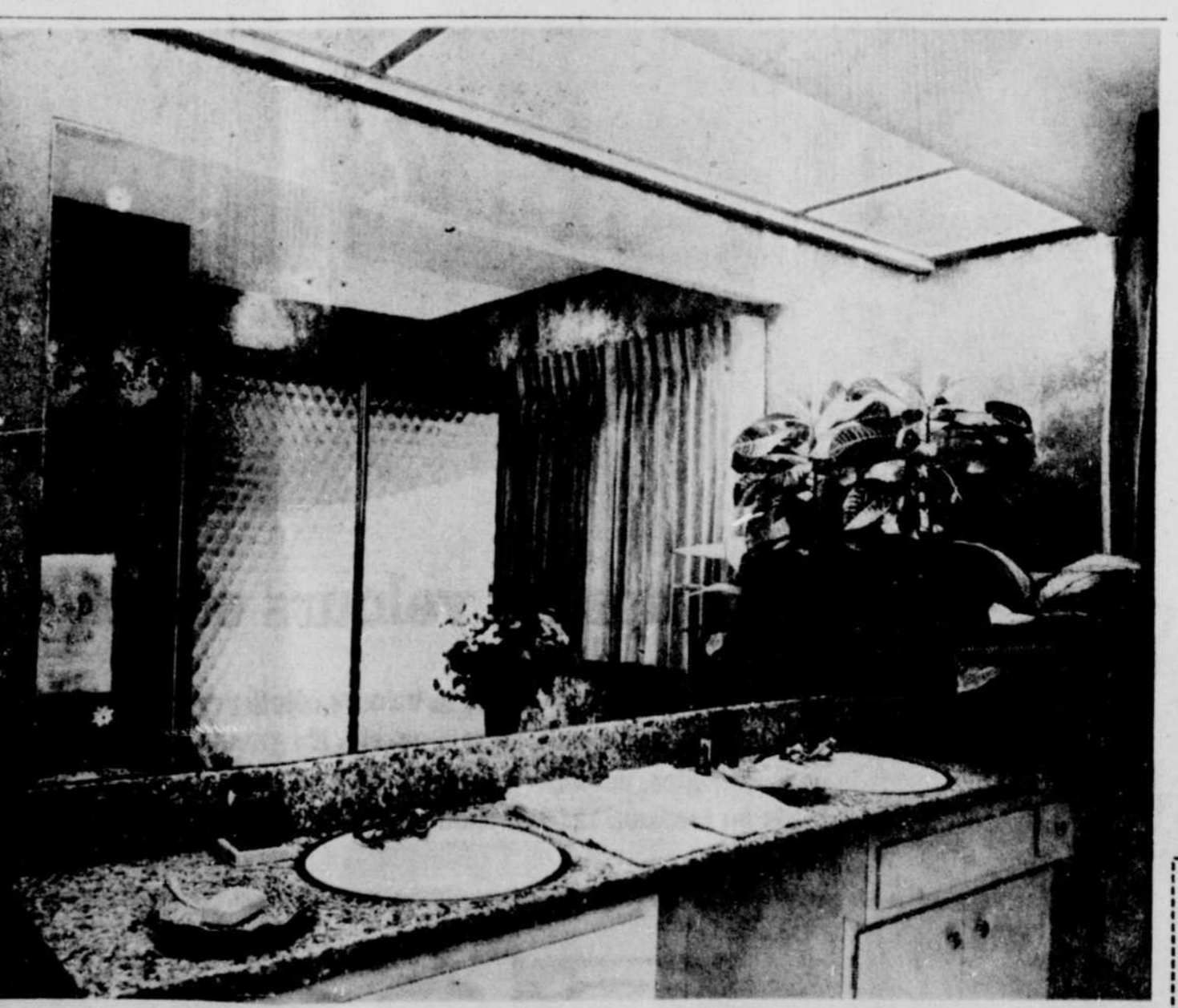
● Voici un nouveauté en fait d'idées pour l'éclairage d'une salle de bains, suggérée par les spécialistes en fait d'éclairage. Faites installer un panneau lumineux de lampes fluorescentes au-dessus du miroir du lavabo, comme illustré ici. Ce panneau comprend quatre rangées de lampes fluorescentes, deux rangées non voisines étant actionnées par des commutateurs différents. Un commutateur actionne deux rangées de tubes fluorescents de luxe blanc froid, qui donnent une lumière comparable à la lumière du jour — pour assortir les coloris et se maquiller pour les activités au grand air en plein jour. Le deuxième commutateur actionne deux rangées de tubes fluorescents de luxe blanc chaud, qui sont préférables pour assortir les coloris et se maquiller pour sortir le soir.
