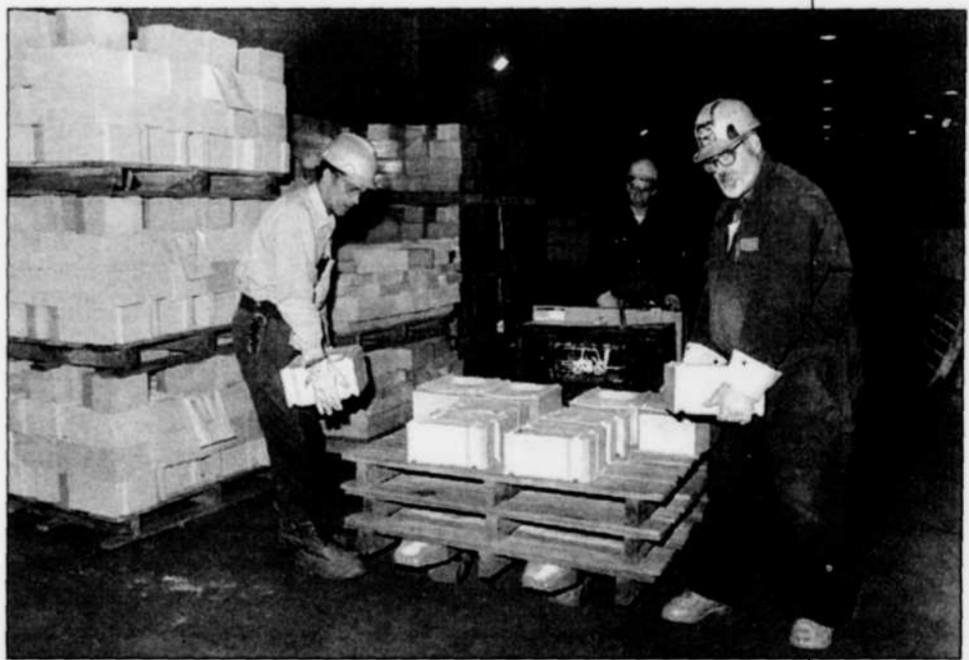
◆ Pas moins de 4 000 tonnes de briques seront utilisées pour reconstruire le four de cuisson ouest. D'ailleurs, la réception et la remise en palettes des briques sont effectuées par une équipe d'employés du CPA.
