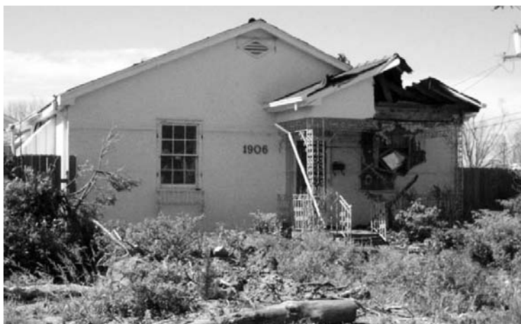
Figure 2 : Rehausser, reconstruire, abandonner... que faire ?
