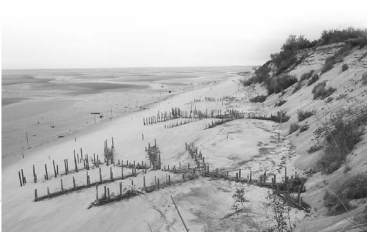
L'implantation d'épis sur la plage permet, dans certaines circonstances, de capter le sable en transit et ainsi de protéger la base du talus de l'action des vagues.
