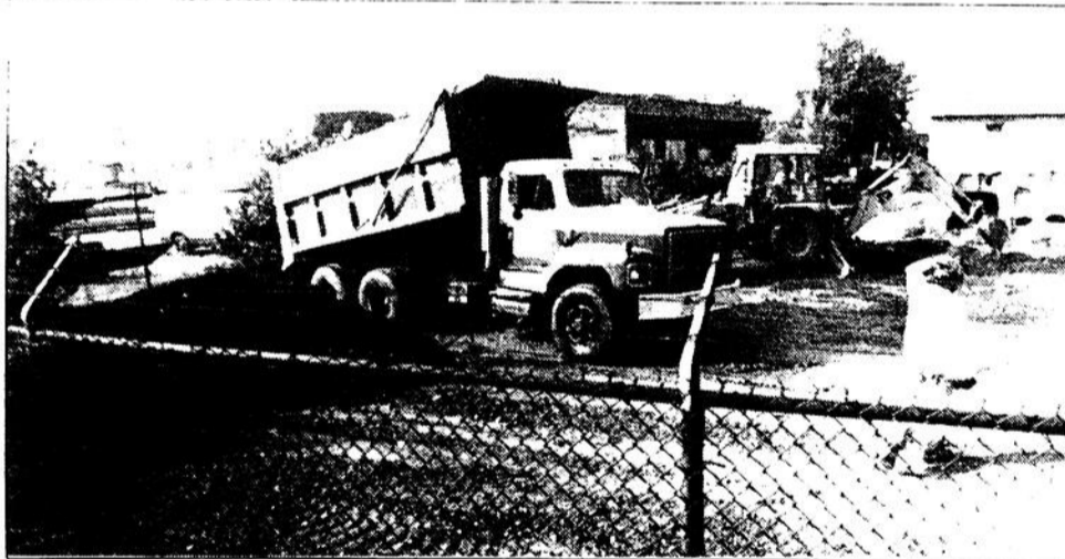
Les travaux de pavage du terrain de la compagnie Balmet ont débuté jeudi.
