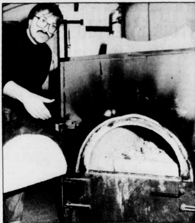
L'ancienne porte de l'incinérateur laisse voir les fissures par où fuyait la fumée. À gauche, M. Mario Provençal montre l'incinérateur défectueux.
