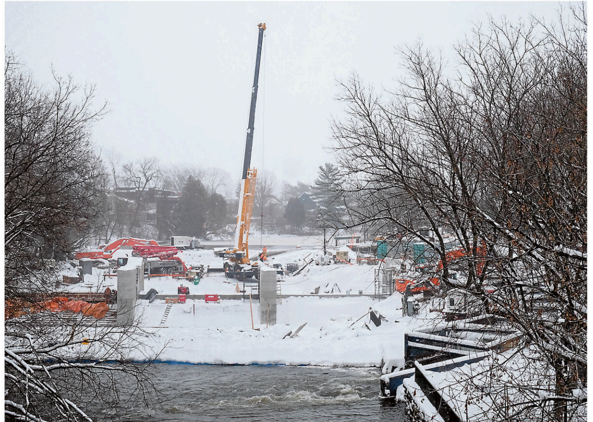
Le chantier de mise à niveau du barrage du lac Boivin, au centre-ville de Granby, accuse du retard. Le nouvel ouvrage sera vraisemblablement mis en service en février, selon Daniel Surprenant. — PHOTO ALAIN DION
