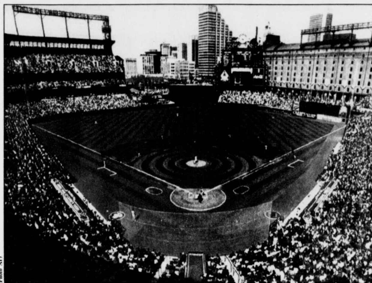
Les architectes du Camden Yard ont respecté la tradition du baseball lorsqu'ils ont conçu le nouveau domicile des Orioles.
