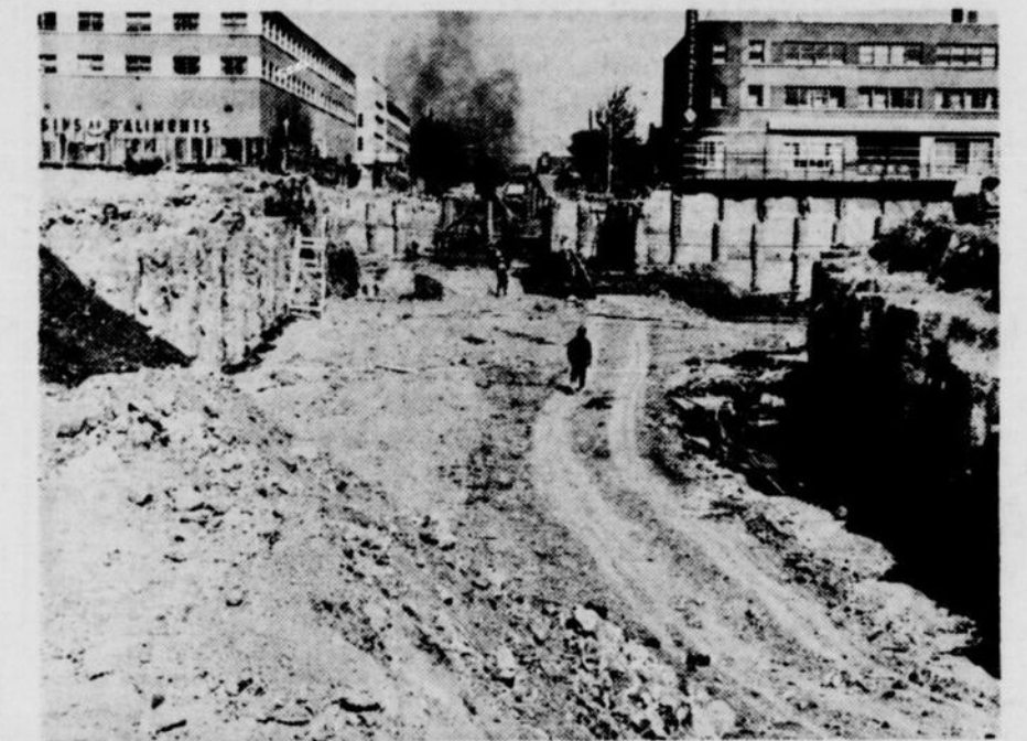
La construction de la station Berri-de Montigny se fait en tranchée, à l'intersection des rues Berri et de Montigny. A gauche, le Palais du Commerce; à droite, le terminus des autobus.
