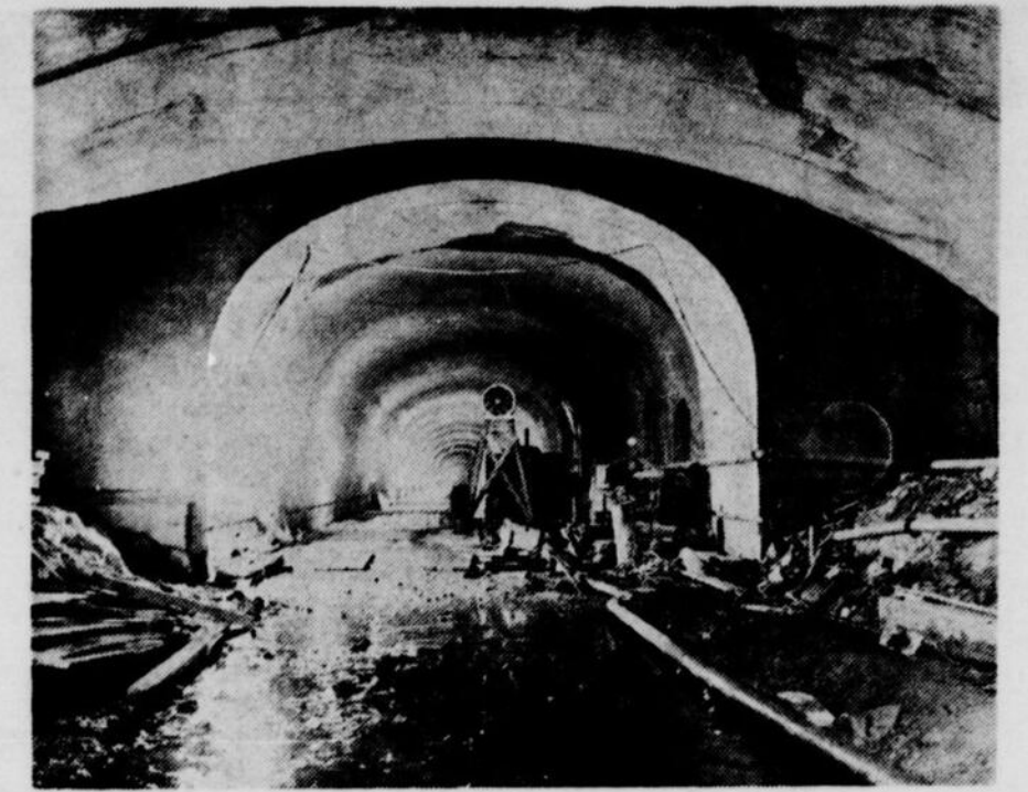
Une station-tipe de métro, une fois terminé le bétonnage. Le tunnel, 16 pieds de hauteur; l'emplacement de la station, 18 pieds.
