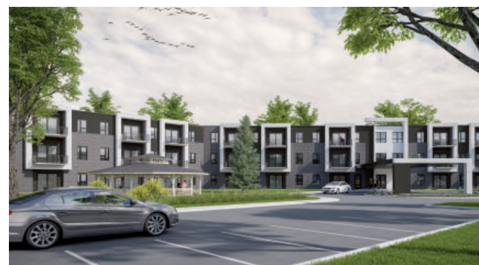
La construction phase 1 du Complexe immobilier Le Pur, à Saint-Janvier, avance bien. On prévoit accueillir les premiers locataires dès juillet 2018.
