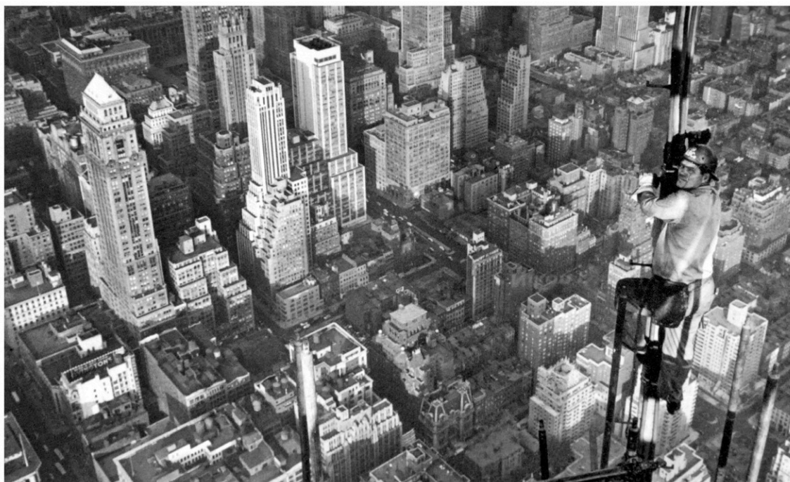
Le journaliste et auteur Michel Moutot détruit le mythe voulant que les Mohawks n'éprouvent pas de vertige dans les hauteurs. En réalité, ils le combattent. Photo prise en 1950 montrant un monteur d'acier qui fixe une antenne de télévision temporaire au sommet de l'Empire State Building.
