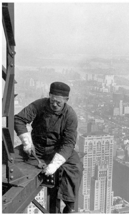
Monteur d'acier au sommet de l'Empire State Building
