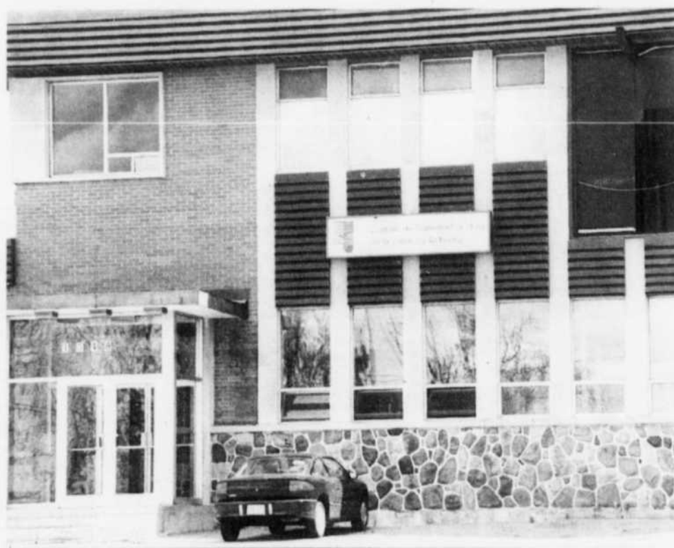
La station d'eau potable date des années 60.
