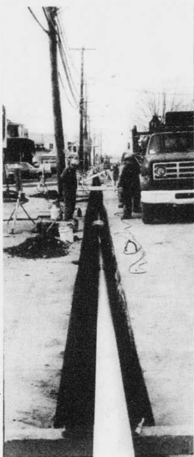
Les employés de la firme Antagon de Ville Saint-Laurent s'affairent présentement à la pose des tuyaux d'alimentation en gaz naturel pour Victoriaville.
