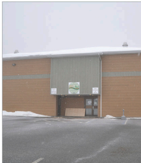
Le centre communautaire, acquis par la municipalité en 2012, subit des travaux d'amélioration à chaque année.
