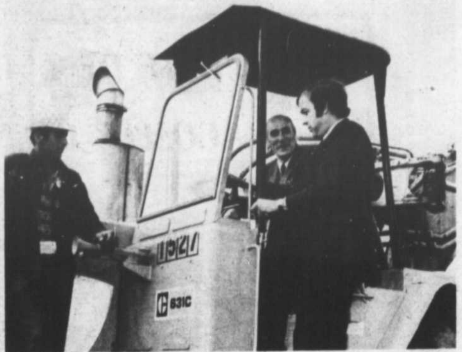
Le Ministre Pinard prenait part à l'inauguration des travaux de l'autoroute 40. Les Pavages Nicolet Inc. exécuteront les travaux d'asphaltage à l'automne 73.
