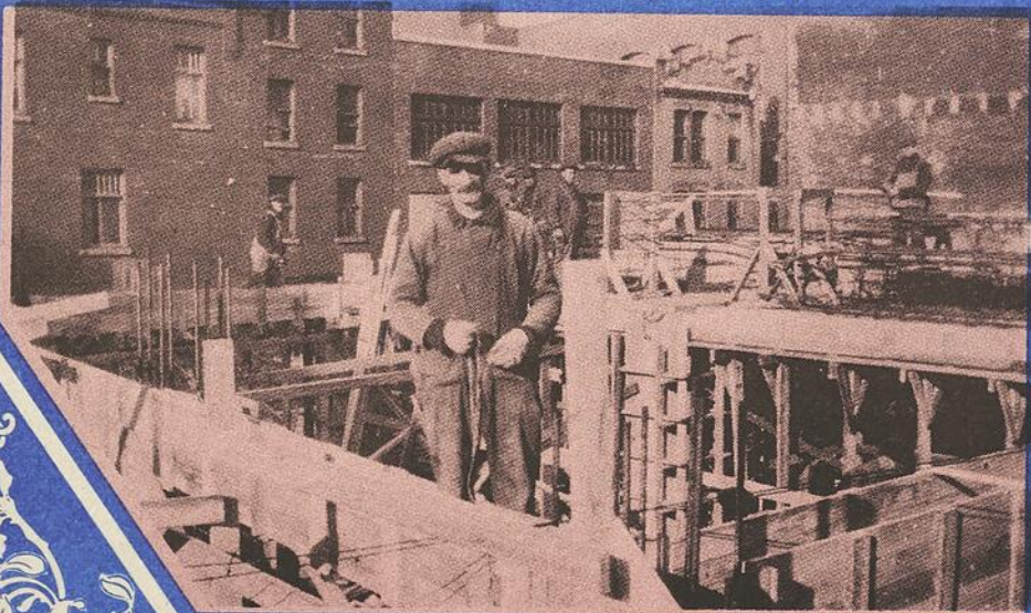
Edmond Fournier, charpentier-menuisier, lors de la construction de la Palestre nationale à Montréal, en 1914.
