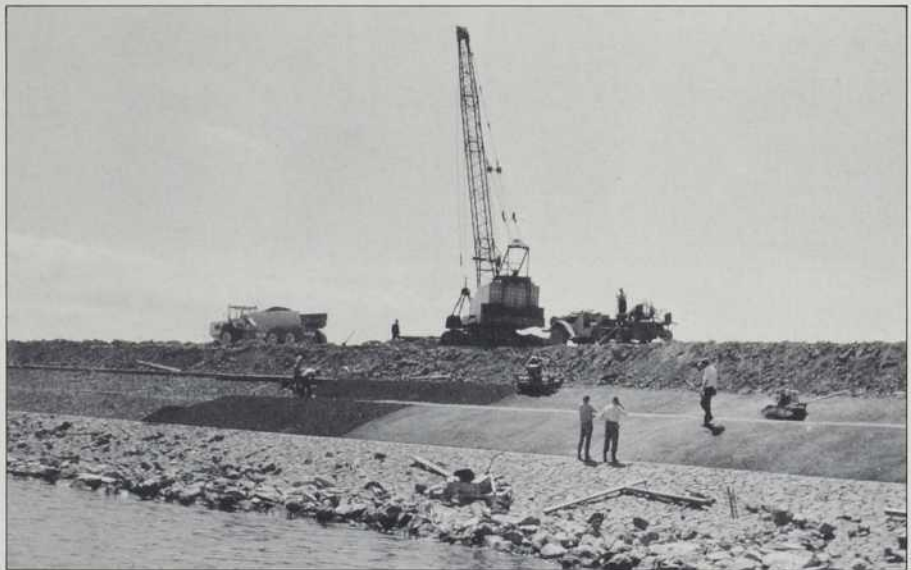
Pour construire un polder dans l'IJsselmeer, on a d'abord érigé des digues de ceinture, faites de plusieurs couches de roches et d'argiles, avec des routes au sommet, à six mètres au-dessus du niveau de l'eau à l'extérieur. Puis on a pompé toute l'eau emprisonnée.
