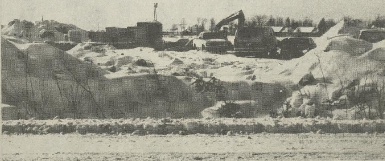
Une fois complété, à la mi-septembre 1990, le centre commercial «Grande place des Bois-Francis» à Arthabaska, un projet de Développements Iberville, abritera une centaine de commerces et fournira de l'emploi à environ 1 000 personnes.
