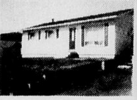
482 Mgr Fortin, St-Pie X. Bungalow, 5 1/2 pièces, salle familiale au sous-sol avec foyer. Construction 1975.
