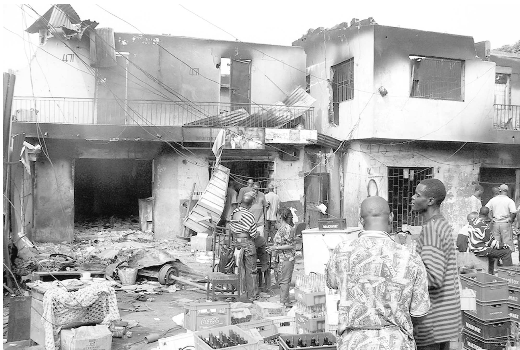
L'incendie dans l'armurerie de la caserne militaire a entraîné plus de 30 fortes explosions qui ont secoué les quartiers d'Ikeja et d'Oshodi, près du centre de Lagos au Nigeria. Hier, les gens venaient constater sur place les dégâts causés par le sinistre.
