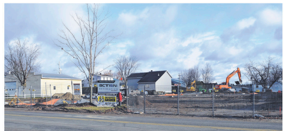
Le chantier devrait être terminé au printemps prochain. (Photo La Voix du Sud – Éric Gourde)
