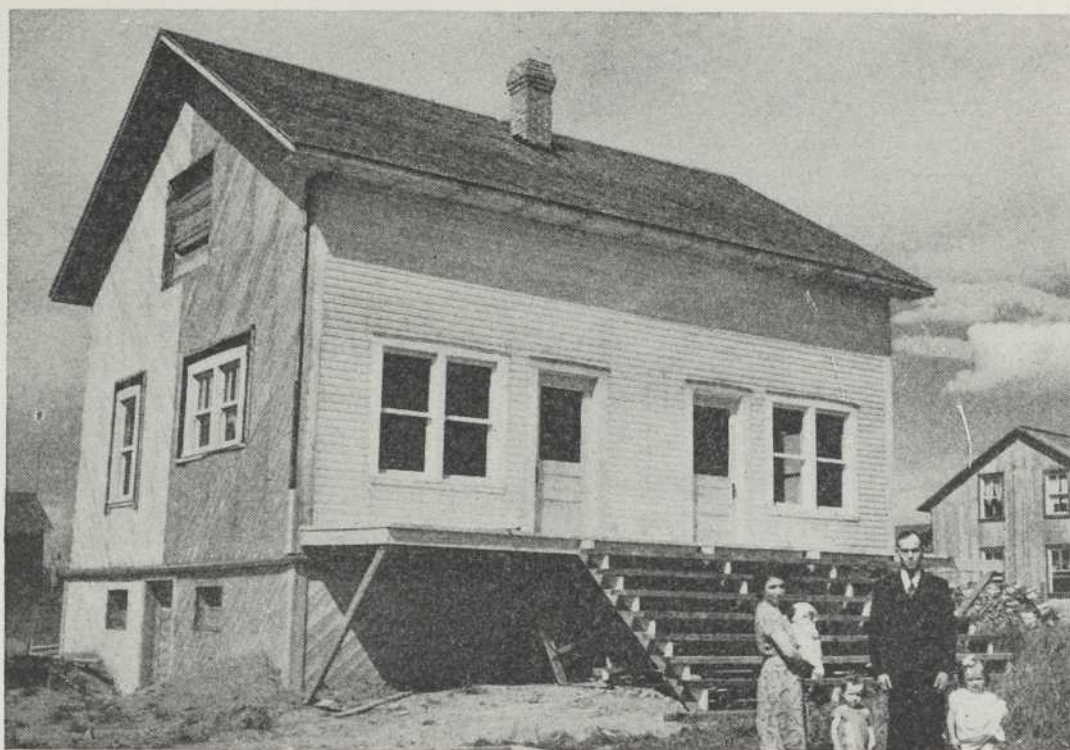
M. Léon Briand et sa famille, en face de sa nouvelle maison en construction. (lot \frac{1}{2} Est 33, rang 3 Roquemaure).
