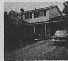
6-BOUCHERVILLE: 4 chambres, foyer, piscine creusée, secteur paisible. L. SIMARD, 655-1375.
