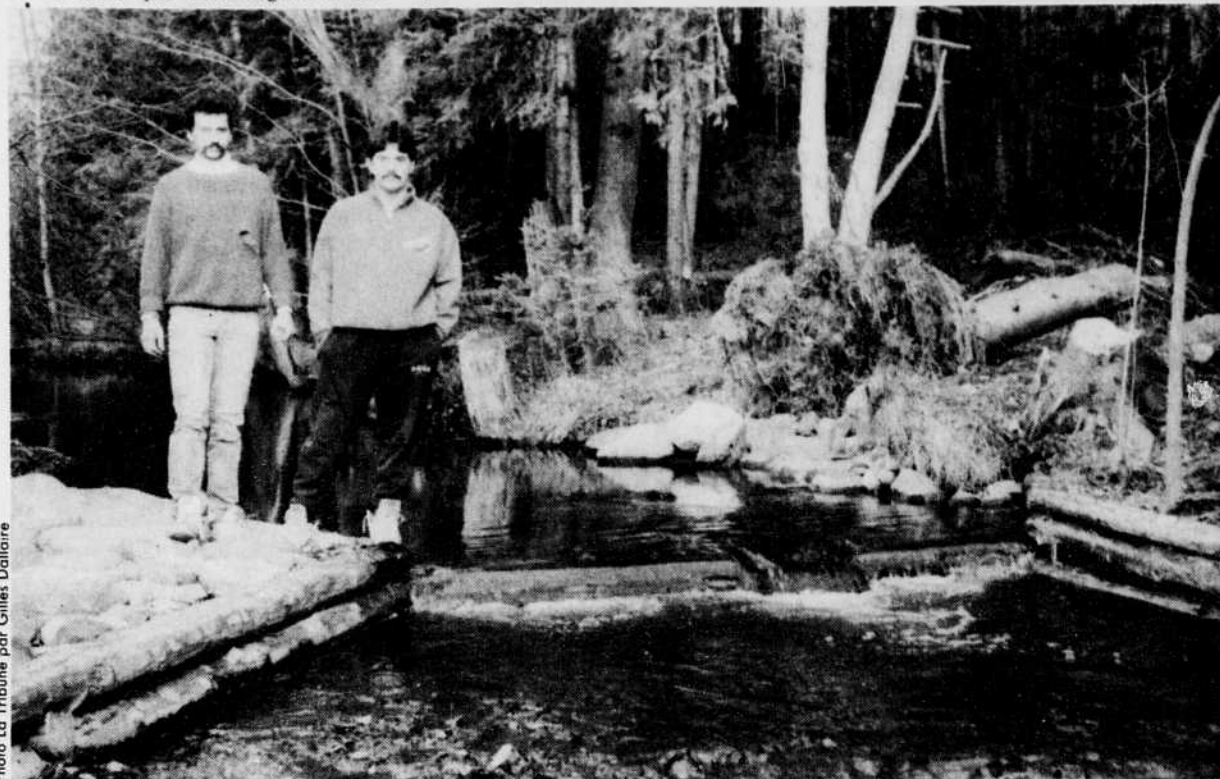
Paul Descôteaux et René Saint-Pierre montrent un seuil facilitant tout à la fois l'oxygénation de l'eau et la montée du poisson aménagé dans le lit du ruisseau West, non loin de la route reliant Austin et Bolton Centre.
