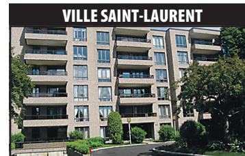
VILLE SAINT-LAURENT • Dim. 14-16h. Pour rendez-vous 514-917-1069 • 925, cr. du Ruisseau. Fiche MLS 17111759 • 5½ sur le parc! Totallement rénové. Occ. 60 jours • 419 500$ - Garage intérieur et extérieur. • RE/MAX du Cartier, Lise Giroux, 514-917-1069
