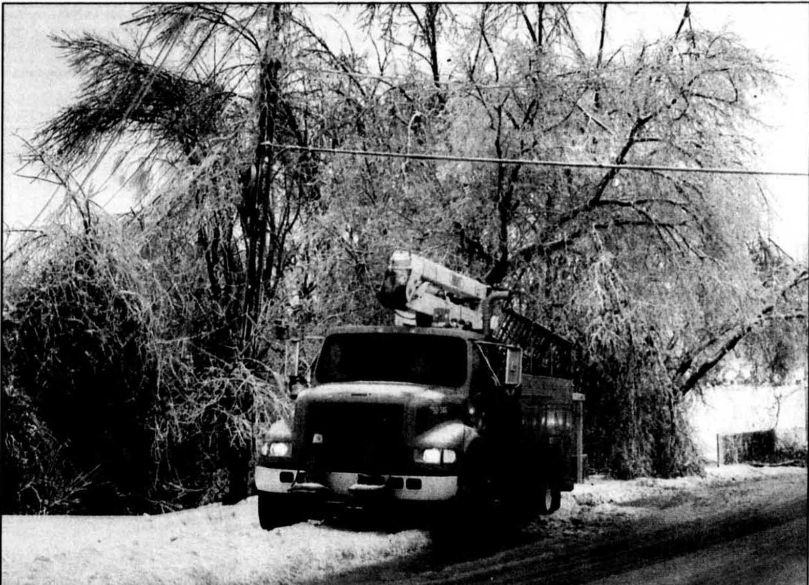
Une scène qu'on a vu se répéter souvent cette semaine : un camion d'Hydro-Québec à proximité d'un poteau de fils électriques endommagés par le verglas. L'Outaouais entier a croulé sous la glace cette semaine, obligeant la Croix-Rouge à décréter des mesures d'urgence et à ouvrir plus de 18 centres d'hébergement temporaires pour les sinistrés privés d'électricité. À lire dans nos pages : la réaction de la directrice de la Croix-Rouge, des conseils du Bureau d'assurances du Canada et que faire avec le contenu de votre réfrigérateur...
