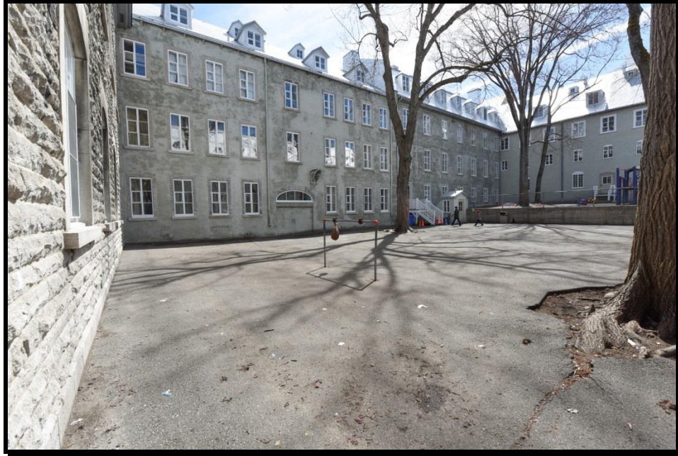
Figure 23. La cour intérieure et le mur nord de l'aile des Parloirs en 2015. En direction sud-ouest. Photo Chantal Gagnon, Ville de Québec.
