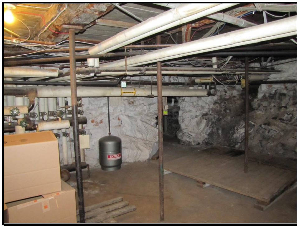
Figure 28. Vue du sous-sol à l'angle sud-est de l'aile Saint-Augustin où les crans rocheux supportent les fondations. L'ouverture visible à gauche permet l'accès au périmètre du corridor et celle de droite dans une section à l'extrémité sud. En direction sud-est, photo Serge Rouleau, A15-02-03.
