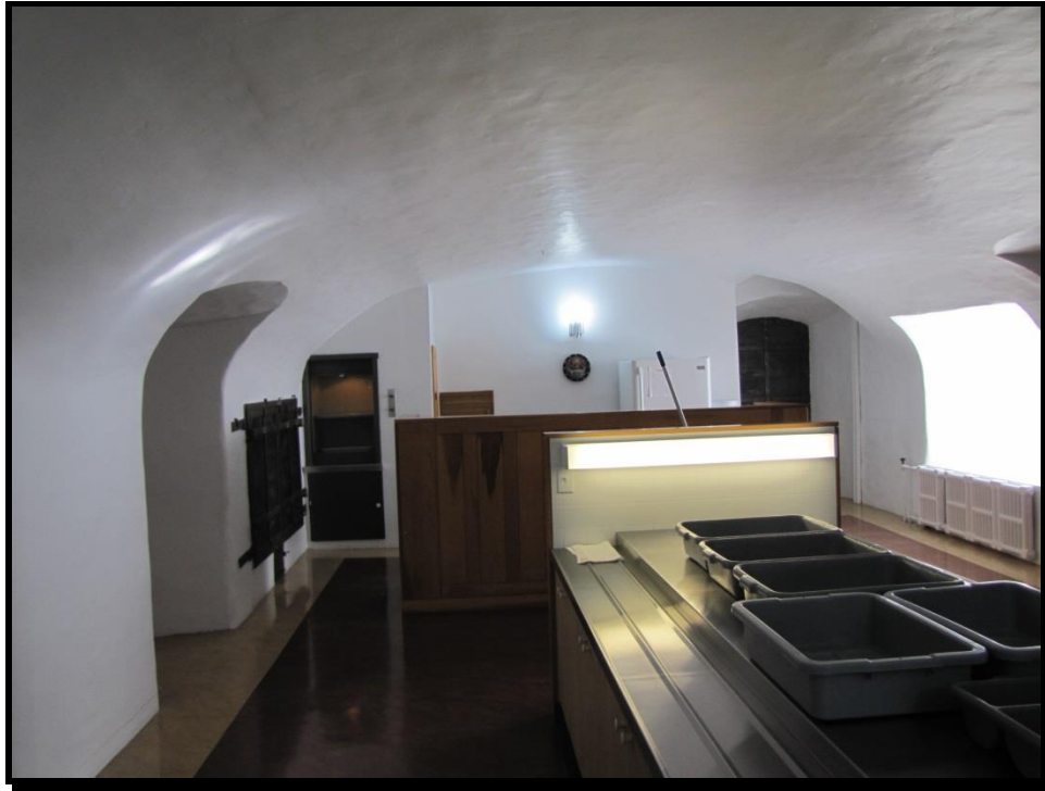
Figure 29. Vue de la portion sud de la voûte des cuisines à l'étage. Photo Serge Rouleau, A2015-02-10.
