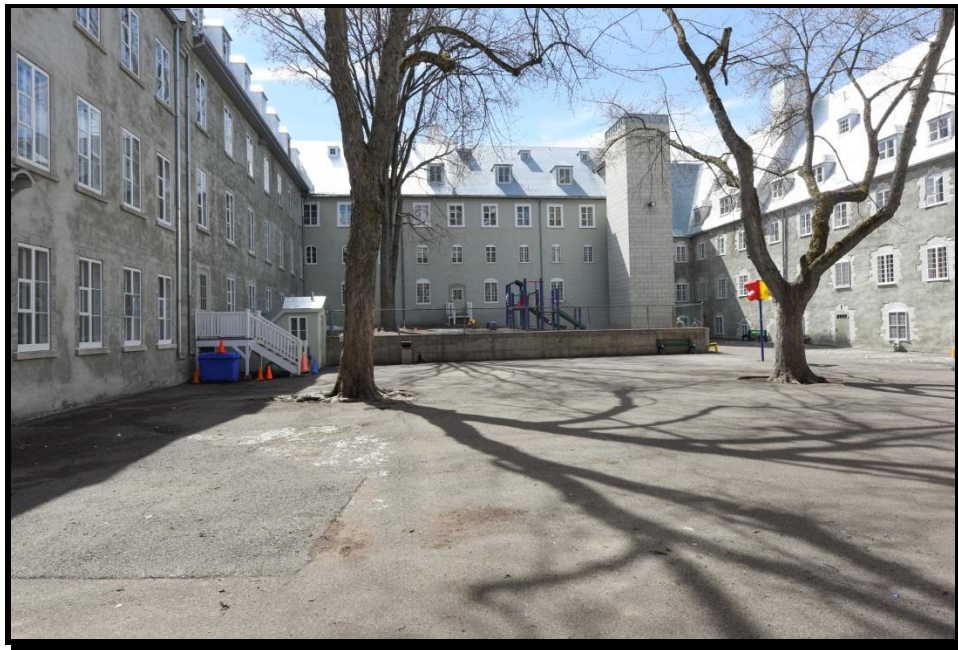
Figure 22. La cour intérieure au printemps 2015. Notez la surface du terrain surélevée près de l'aile Saint-Augustin et la cage d'ascenseur. En direction ouest, photo Chantal Gagnon, Ville de Québec.
